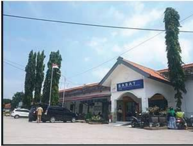
Gambar Stasiun Kereta Api Babad Sumber Google.
